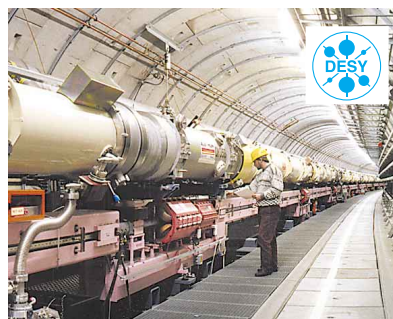
Vue du tunnel HERA au DESY de Hambourg, long de 6,3 km.
