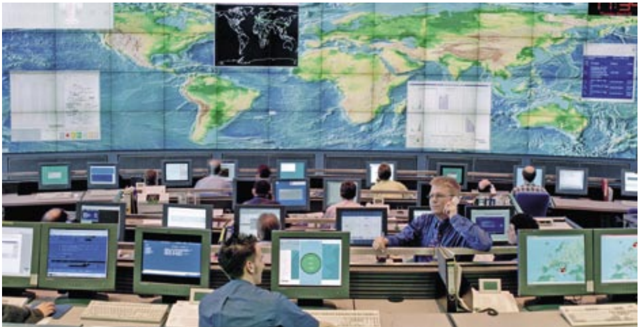
Kontrollzentrum Deutsche Telekom AG
