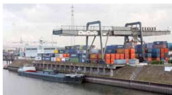
Container-Terminal am Duisburger Hafen (Quelle: SGKV)
