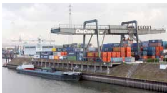
Container-Terminal am Duisburger Hafen (Quelle: SGKV)
