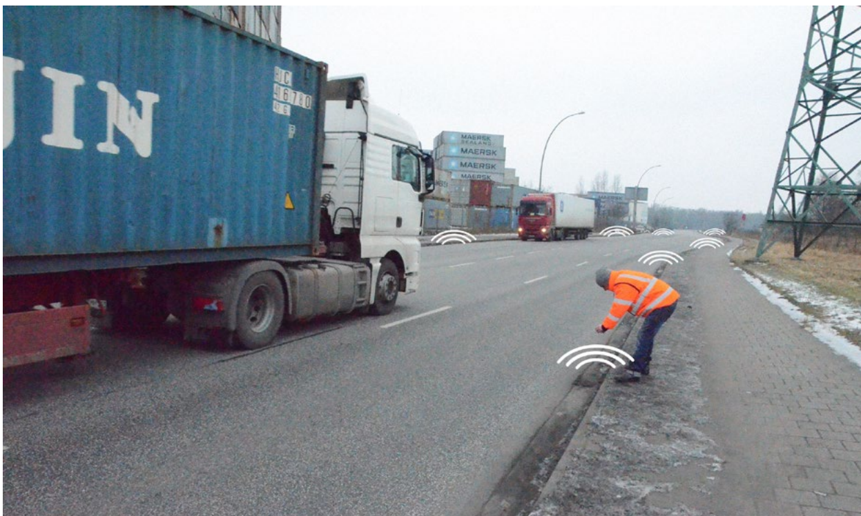
Schwarmsensoren sollen Überschwemmungen im Regen- und Mischwasserkanalnetz verhindern.
