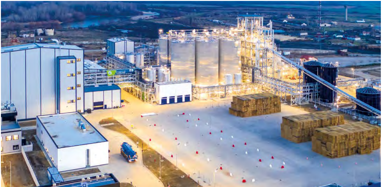
In einer kommerziellen Lignocellulose-Bioraffinerie in Rumänien stellt der Spezialchemiekonzern Clariant Ethanol aus Stroh her.
