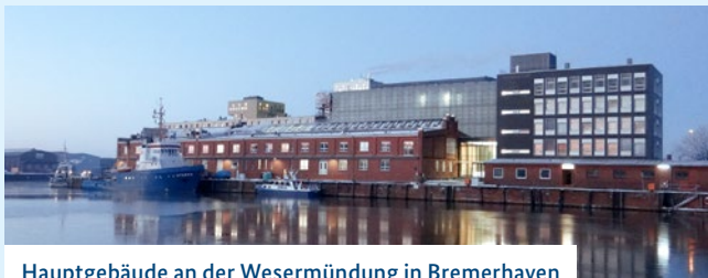
Hauptgebäude an der Wesermündung in Bremerhaven
