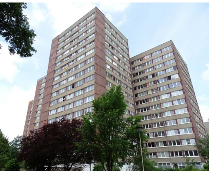
Plattenbau in Frankfurt/Oder wird zum Mehrgenerationenhaus
