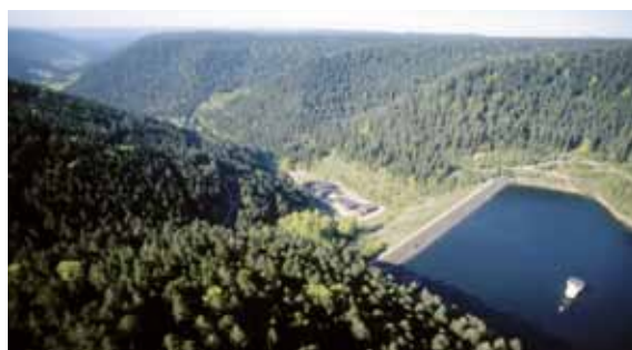
Luftbild einer Talsperre (Quelle: KWL Zweckverband Wasserversorgung Kleine Kinzig)
